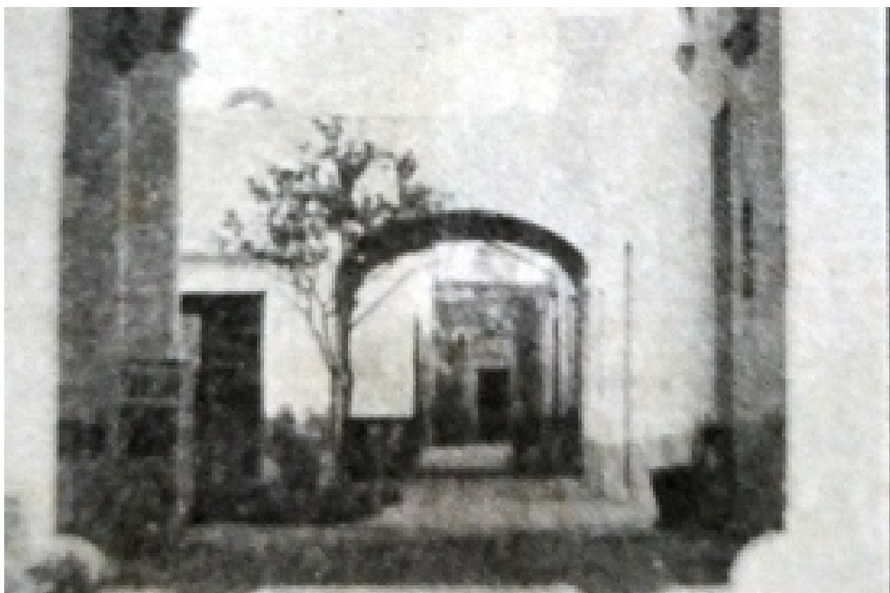
SEGUNDO Y DEFINITIVO EDIFICIO QUE OCUPÓ NUESTRA ESCUELA
